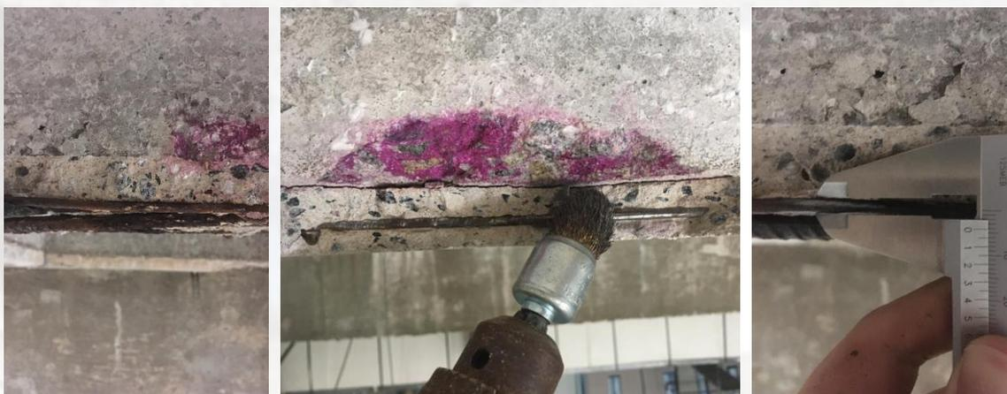
**Figura 17** – Preparação e medida da perda de seção das armaduras.
