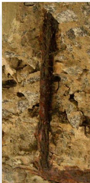
**Figura 2** – Exemplo de corrosão desencadeada por carbonatação (Fonte: acervo particular dos autores).
