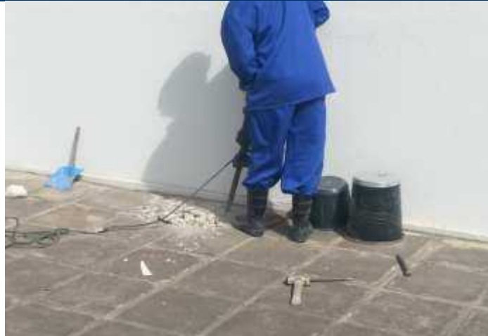
Foto 11 – Remoção das lajotas para inspeção da fundação.
