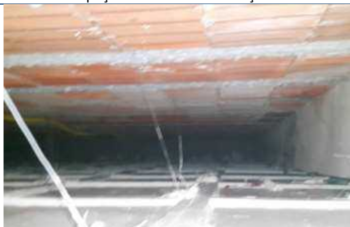
Foto 48 – Inspeção da laje pré-moldada.
