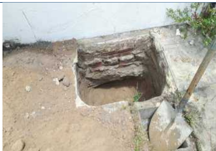
Foto 26 – Verificação dos materiais da fundação.
