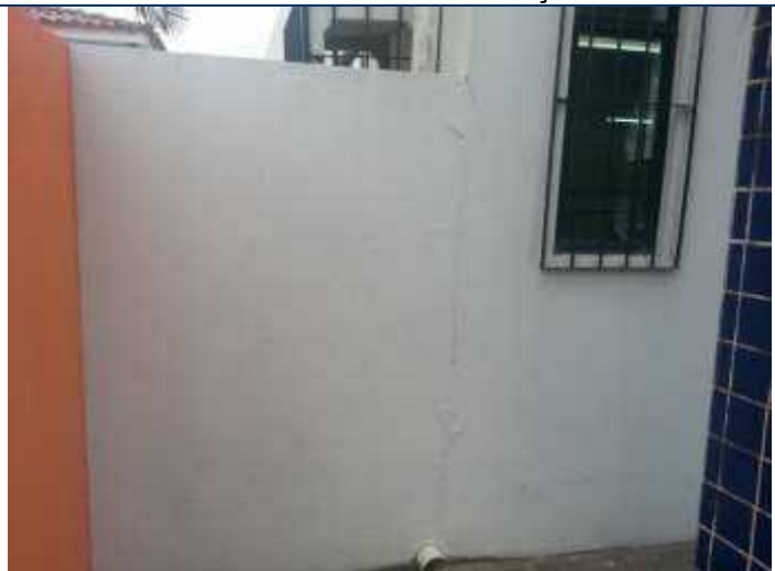
Foto 39 – Fissura no encontro entre o muro frontal e a fachada do edifício.
