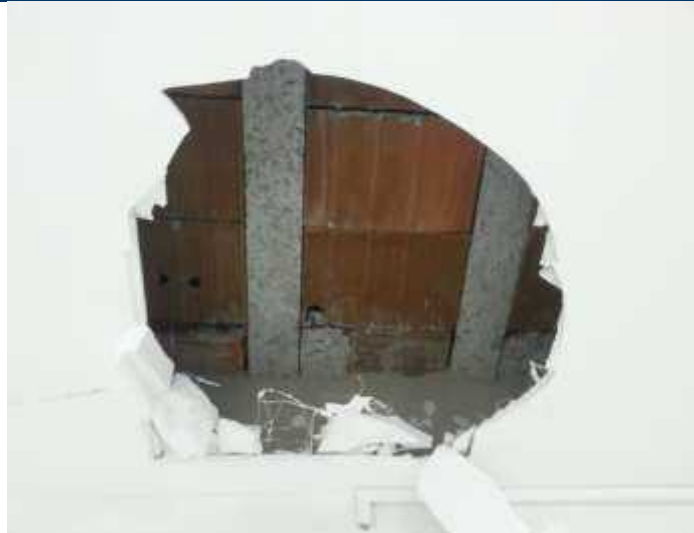
Foto 09 – Remoção do gesso para inspeção da laje.
