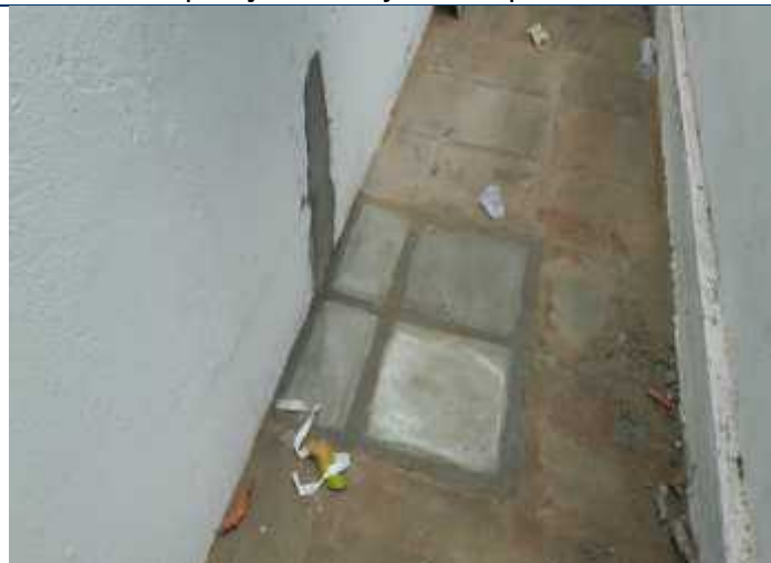
Foto 23 – Reposição das lajotas do piso externo
