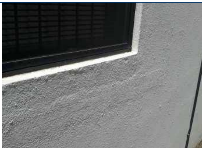
Foto 42 – Recuperação de fissuras e inclusão de contraverga.
