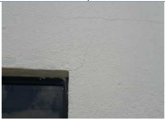
Foto 36 – Fissuras na cinta de amarração.
