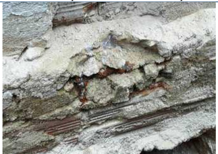
Foto 30 – Presença de oxidação na armadura do radier da edificação.
