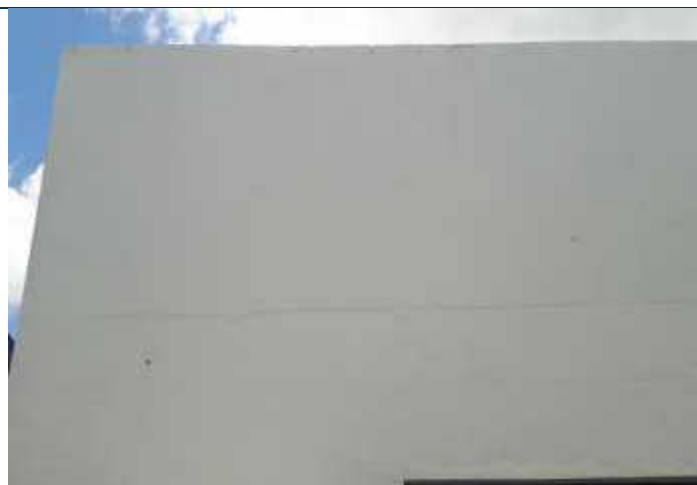
Foto 38 – Fissuras na cinta de amarração.
