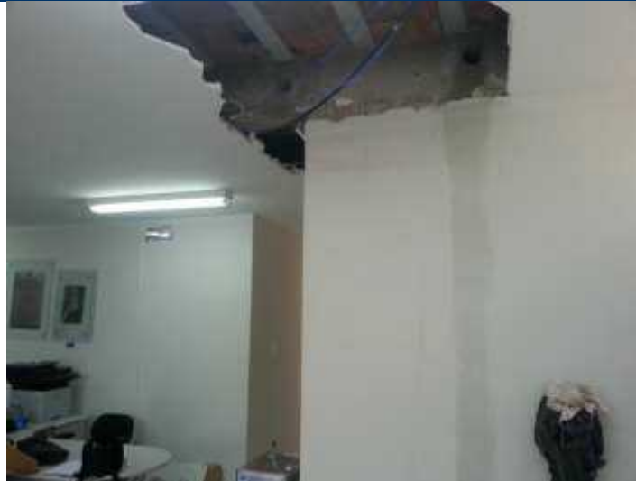
Foto 10 – Remoção do gesso para inspeção da laje.
