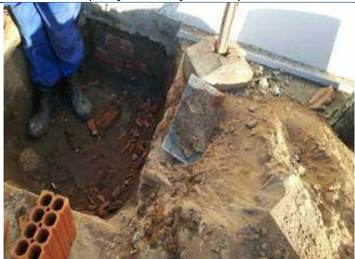
Foto 24 – Compactação do terreno após a inspeção.
