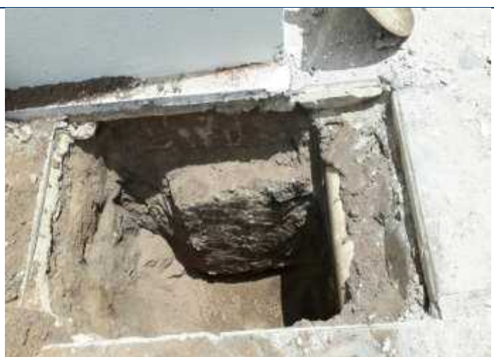
Foto 31 – Localização dos blocos de fundação.
