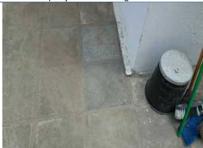
Foto 21 – Reposição das lajotas do piso externo.
