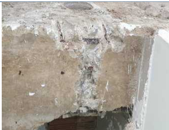
Foto 08 – Verificação da armadura da viga do fórum.
